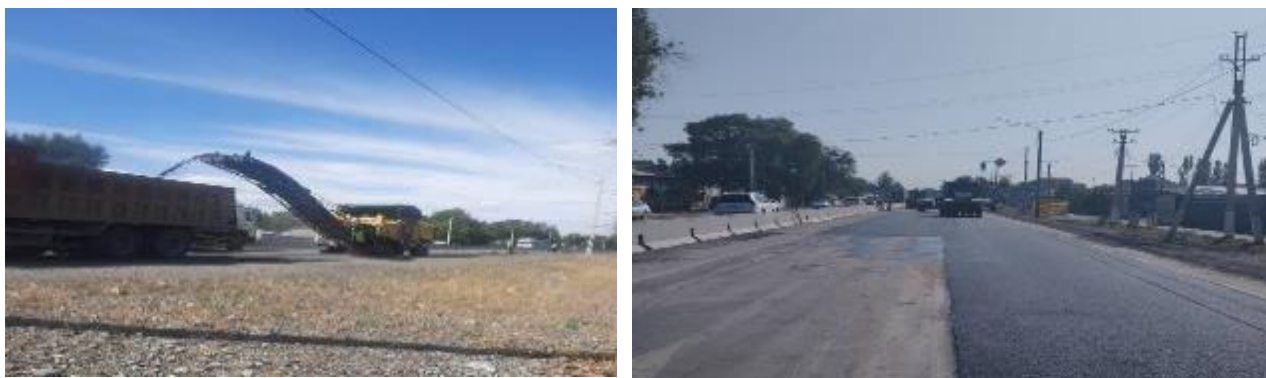
Рисунок 3. Фрезерование и укладка верхнего слоя асфальта, устранение колеи.
