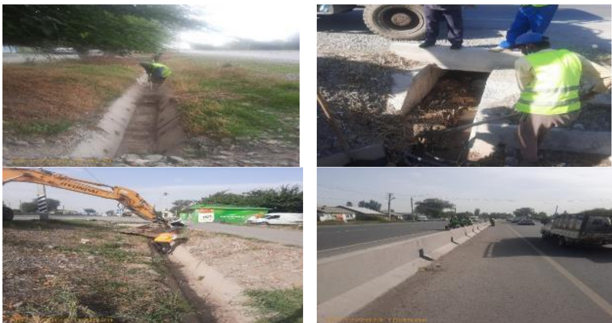
Рисунок 4. Очистка водопропускных лотков и парапетов от скопившегося грунта.
