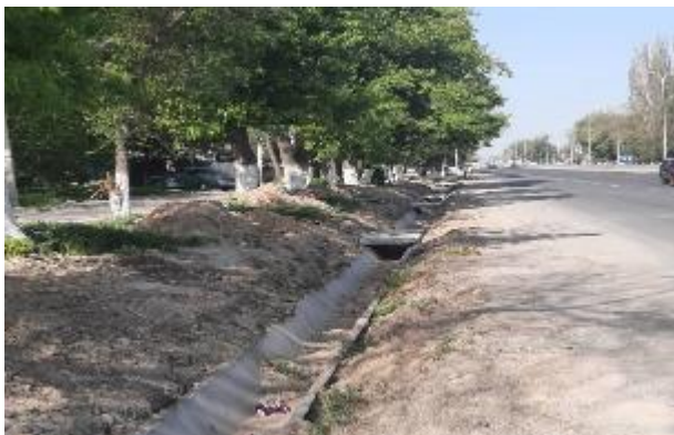
Рисунок 10. Очистка водопропускных лотков.
