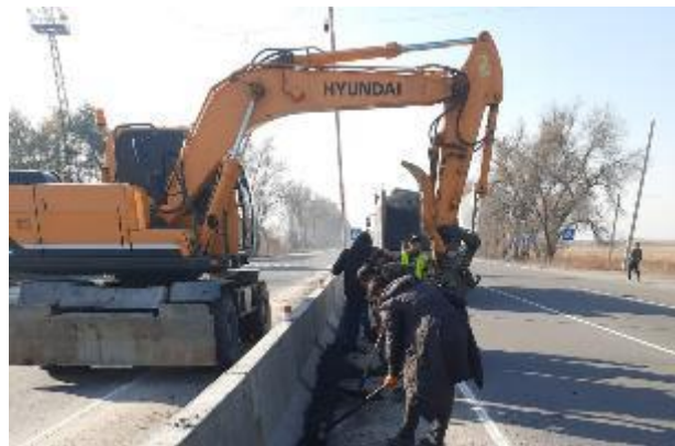
Рисунок 9. Очистка парапетов от земляных отходов и вывоз отходов с дороги
